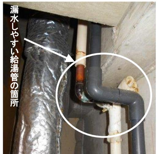
漏水しやすい給湯管の箇所
