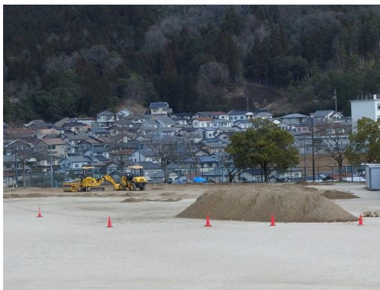
グラウンドの土の入替工事（3月13日撮影）
