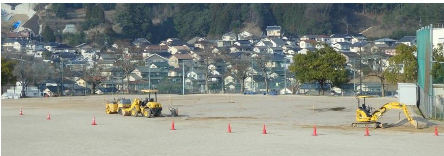
グラウンドの土の入替工事（3月22日撮影）
