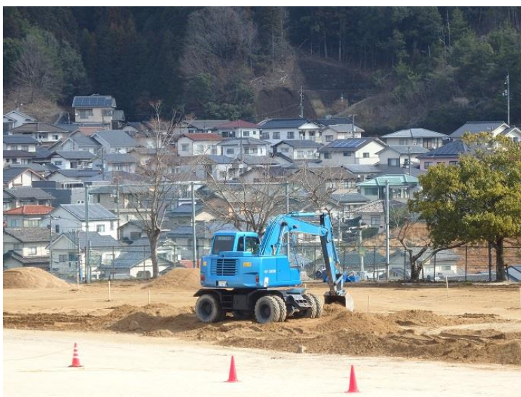
グラウンドの土の入替工事（3月14日撮影）
