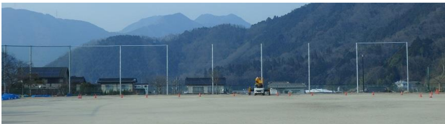
防球ネット改修工事（3月22日撮影）
