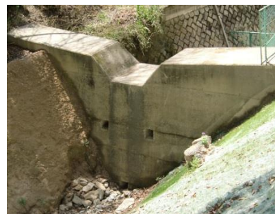
①既設のダム
