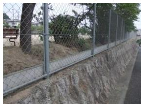
5月の町内一斉清掃の時にB区の多くの方より北第一公園内の土砂が歩道に落下して、掃除に苦労しているとの意見を戴き、安佐南区役所に申し入れたところ、早速6月13日・14日で工事を行い、土砂止めのブロックを築いて貰いました。
