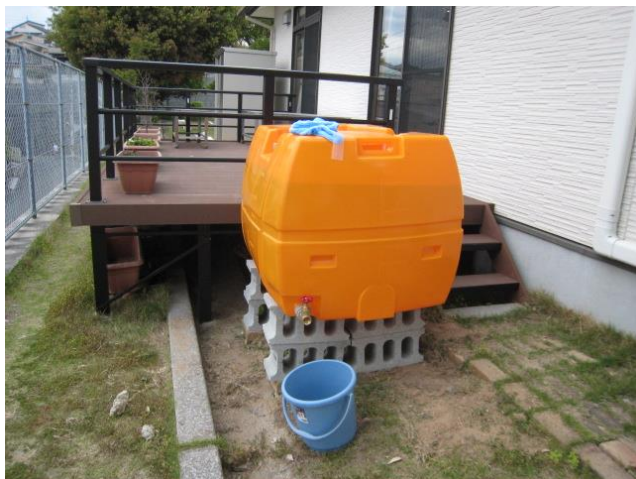
水タンク 500ℓ を設置
