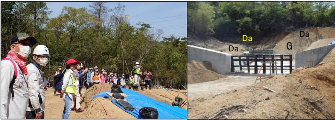
スリット式(透過型)砂防ダムの左岸側(右の写真の右側)で説明を聞く参加者。約2700㎡の土砂をためることができる。2018年の土石流はここでほぼ直角に曲がったが、古い土石流(Da)もダムの上流側で右向きにカーブし、左岸側(写真右)の花崗岩(G)の上に乗っ上がっている様子がわかる。Dbは右岸のDaの下にある。
