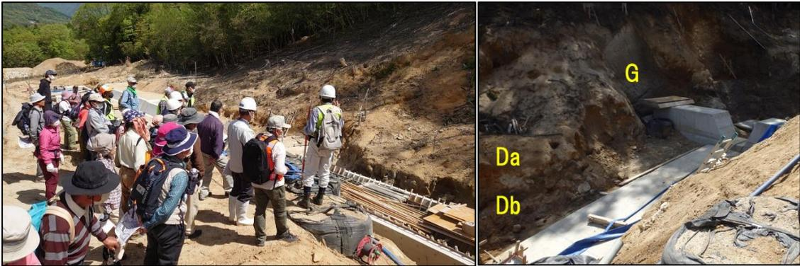
砂防ダム工事現場の下流部 風化花崗岩の所(G)に設置された堰とその付近の右岸側に見られる昔の土石流堆積物の地層(Da:土石流堆積物、Db:炭質物を含む黒っぽい土石流堆積物)
