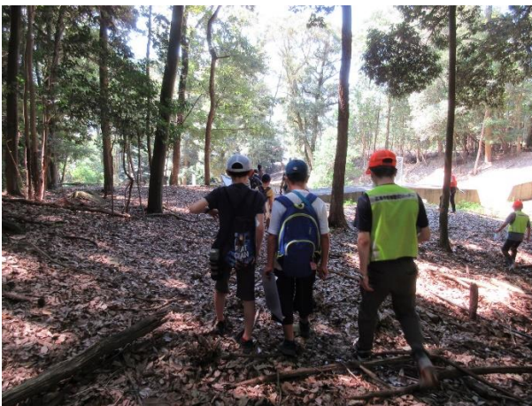
ほとんどが土砂で埋まった治山ダムを見学。
