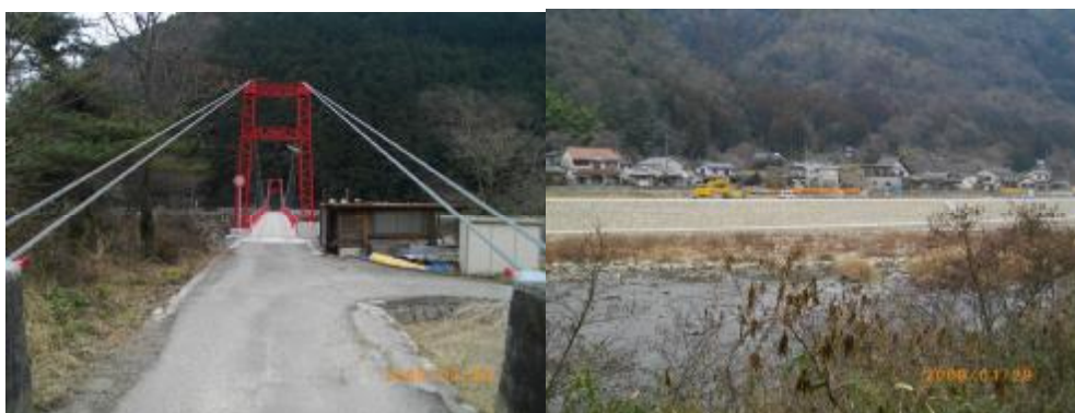
復旧整備された筒瀬橋
