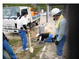
第9公園排水工事
