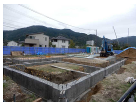
9/16 集会所基礎工事
