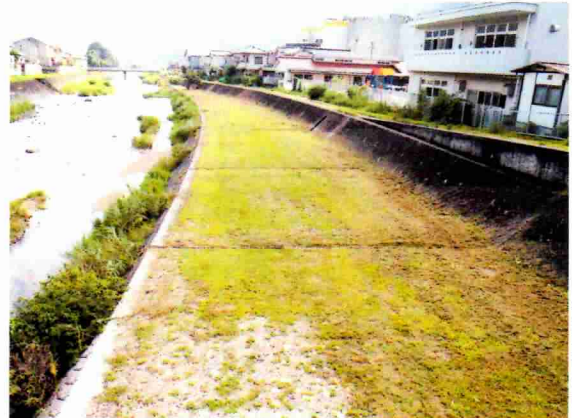
根之谷川 学校橋下流側
