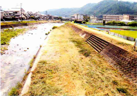
根之谷川 宮橋下流側
