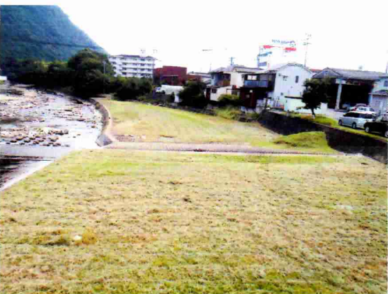
根之谷川 土居橋下流側
