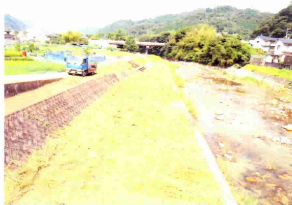
根之谷川 宮橋上流側
