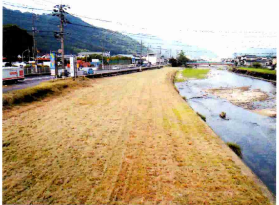
根之谷川 土居橋上流側
