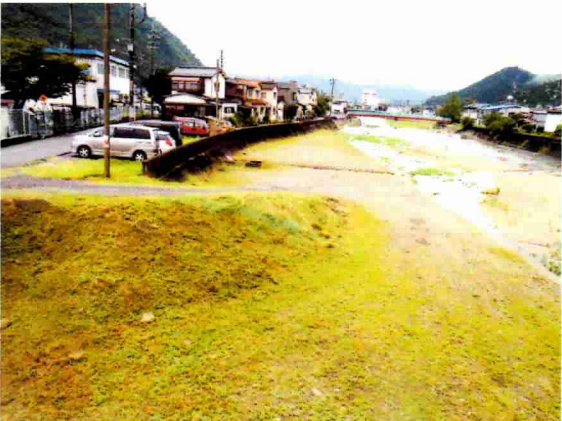
根之谷川 三人橋下流側
