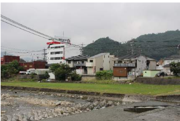
根之谷川 土居橋下流側
