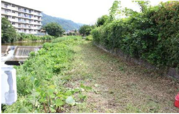
根之谷川 山田橋上流側
