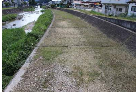
根之谷川 学校橋下流
