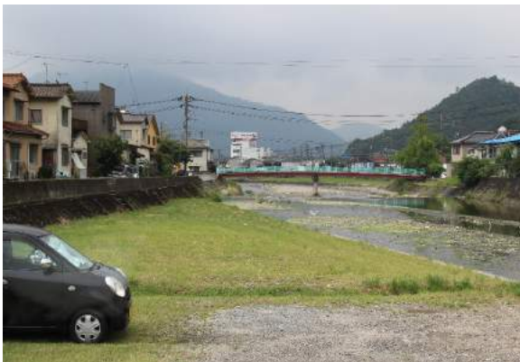
根之谷川 三入橋下流側
